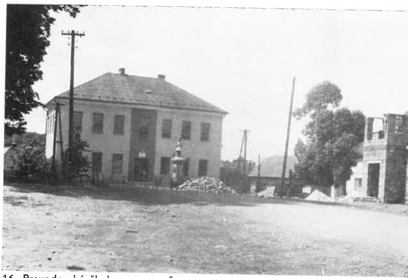
16. Provodovská škola po opravě
